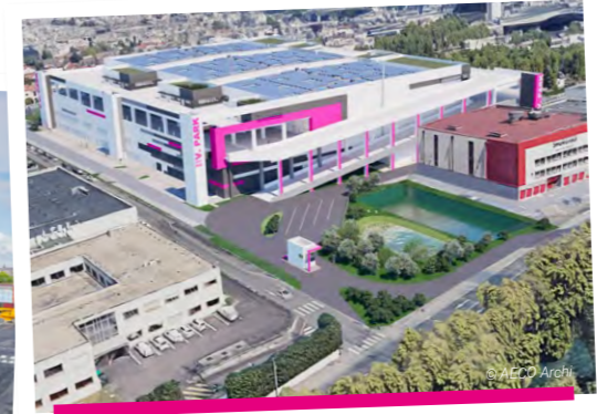
OCTOBRE Lancement des travaux de CADENCES - Bezons (95)
