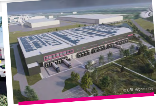
NOVEMBRE Lancement des travaux du Havre (76)
