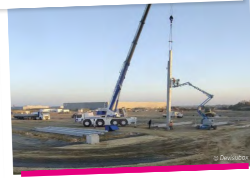
JUILLET Lancement des travaux de Chavagnes A (85)
